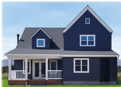
施工：メープルホームズ静岡中央
